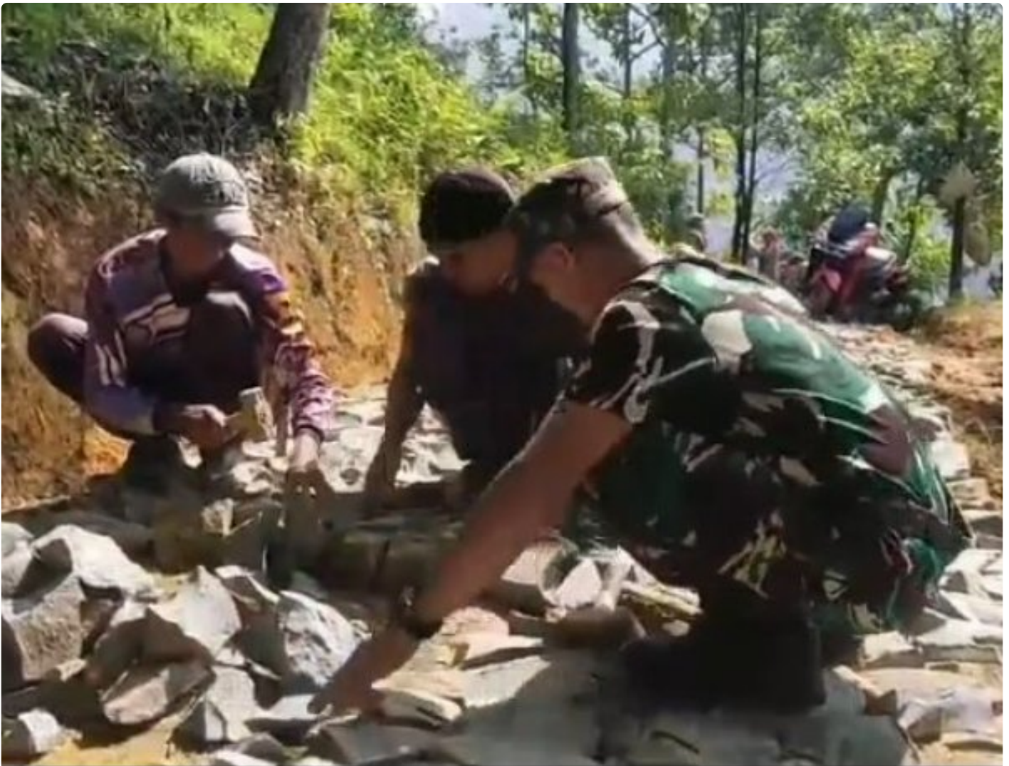
Gotong royong membangun jalan
